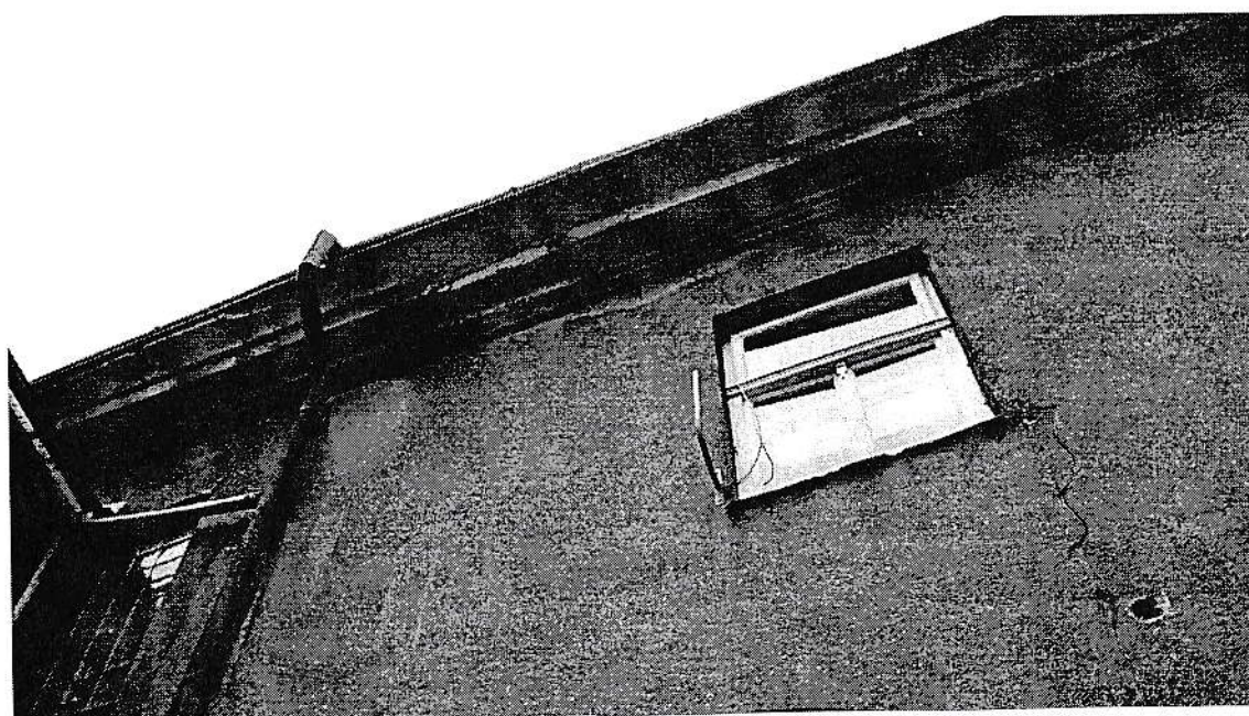
Severní průčelí refektáře. Omítka odpadává od konstrukce zděné římsy – nebezpečí úrazu. Svislá trhлина v obvodovém zdivu na styku parapetu a plné stěny.
