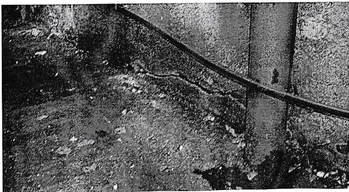
Severní průčelí bývalého refektáře – detailní pohled na vodorovnou trhlinu v blízkosti zaústění okapního svodu do terénu. Trhlina je způsobena chybným odvedení dešťové vody, která narušuje omítku a zdivo.
